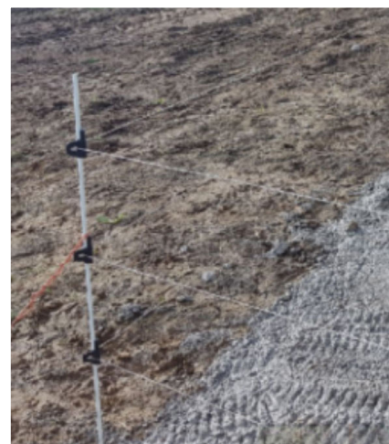
Clôture extérieure : 3 fils électrifiés
